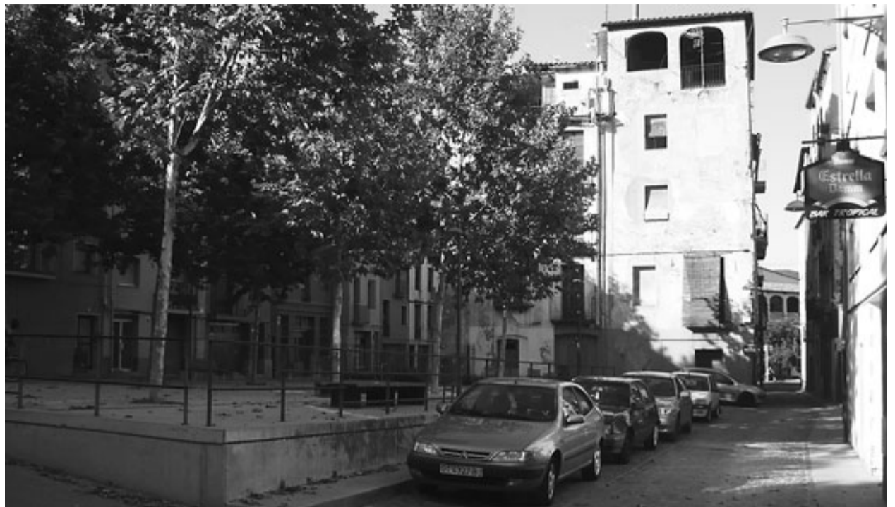
Una vista d'ahir a la tarda de l'actual passeig de la Muralla, amb els últims edificis al fons per enderrocar. / J.C.
