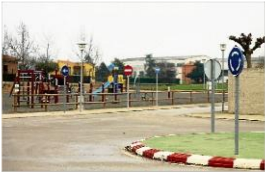
Vilobí d'Onyar Instal·len noves lluminàries a la zona de Cal Ferrer Pagès
