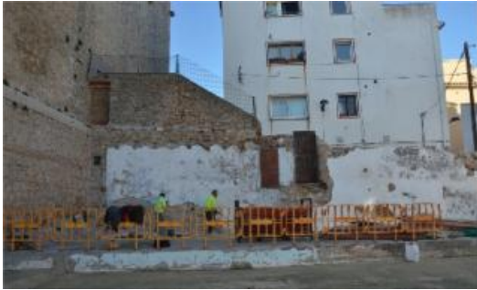
Les obres de reforma que s'estan portant a terme a la plaça de l'Escala.
