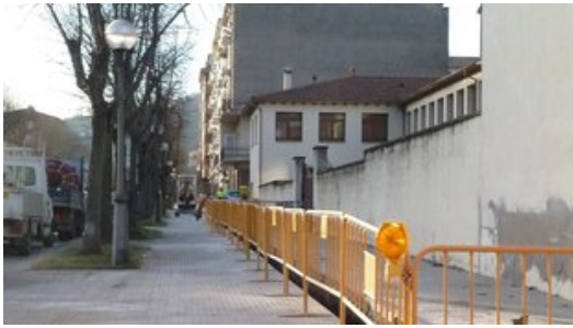
Les obres de Can Parés. Foto: J.C.
