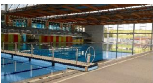
La piscina de Lloret de Mar, pràcticament acabada, en una imatge recent de l'interior.
