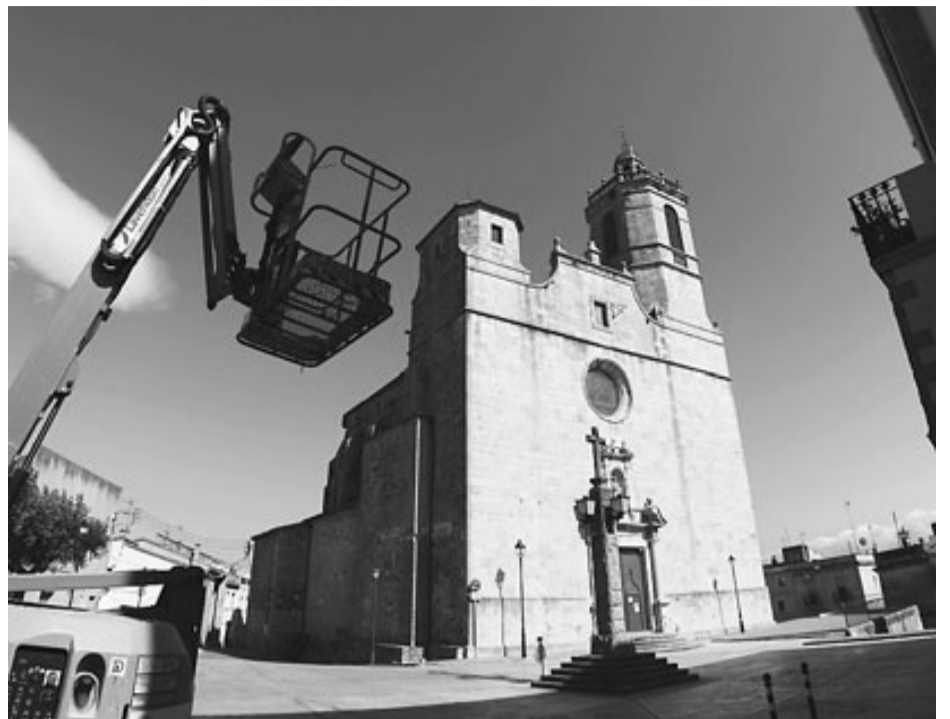
Inici dels preparatius per a les obres a la plaça del Castell, ahir. / LLUÍS SERRAT
