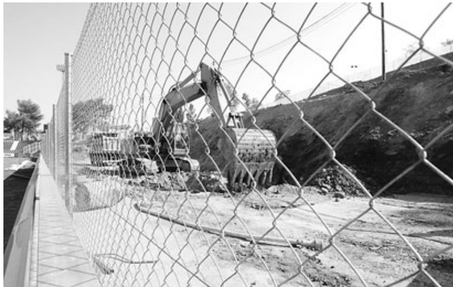
Una excavadora, ahir en els treballs a Montilivi. / EUDALD PICAS
