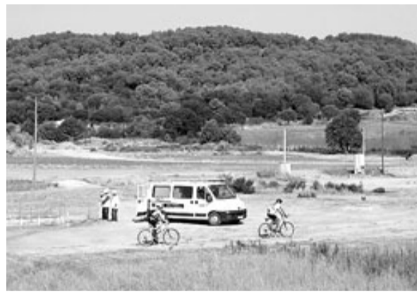
Obres de la carretera C-31, al terme de Palamós./ A.V.
