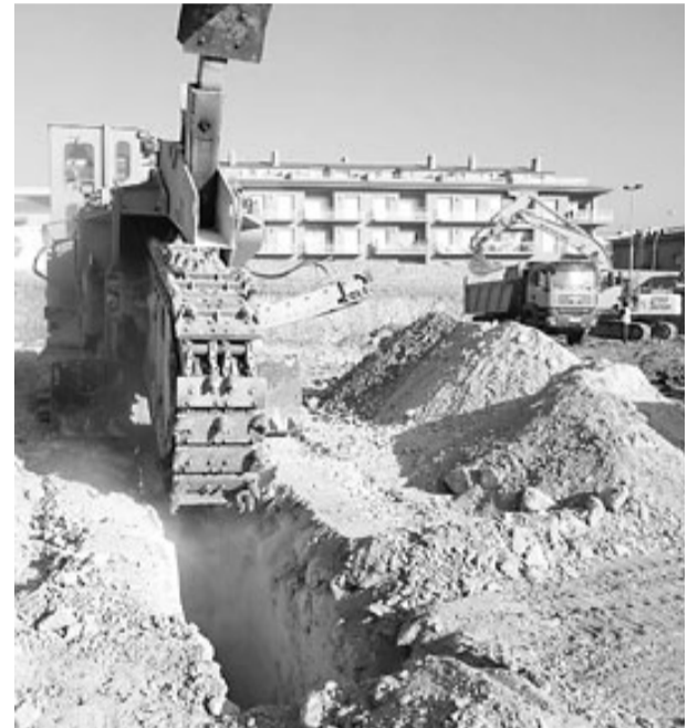
L'excavació que es fa a la plaça Catalunya de l'Escala.
