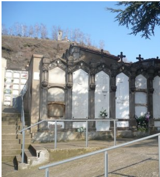
Una vista parcial d'una de les vies on s'han de dur a terme les obres. Foto: J.C.
