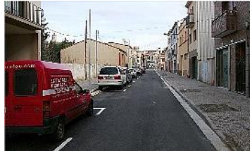
El carrer Tomas Boada, amb les obres gairebé acabades. j.m. bartomeu
