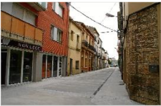
Banyoles Acaben les obres de remodelació del carrer Colom
