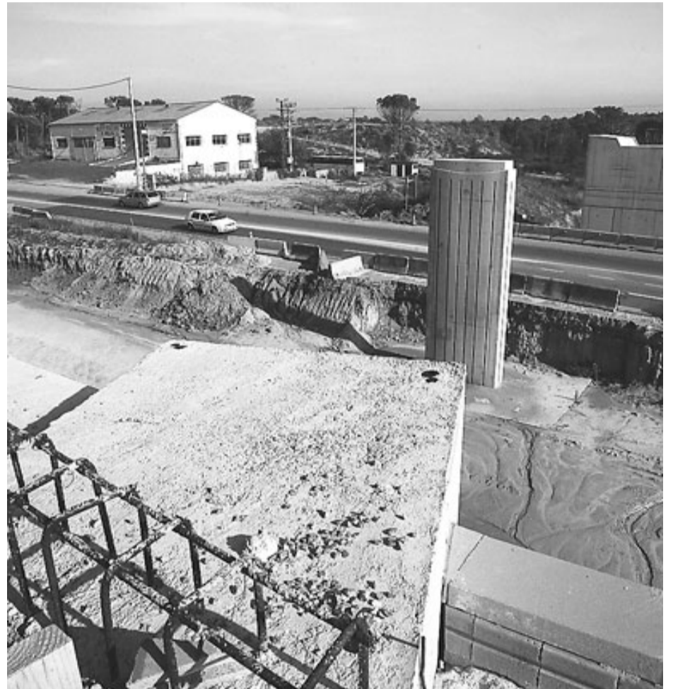
Les obres de l'N-II aturades entre Sils i Caldes. / MANEL LLADÓ
