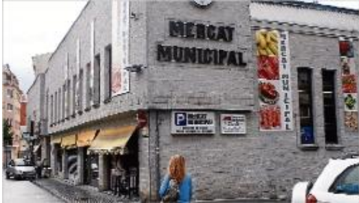
La façana actual del mercat, que el govern voldria renovar.
