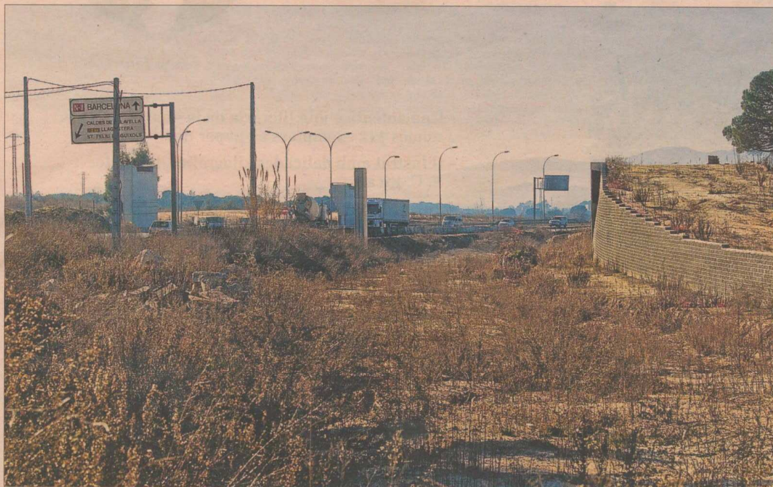
A mig fer. El tram readjudicat, de 6,6 quilòmetres, ja va estar en obres però les tasques es van abandonar el 2009 en el seu estat inicial perquè la constructora va fer fallida. Avui, és una de les zones més perilloses de l'antiga N-II
