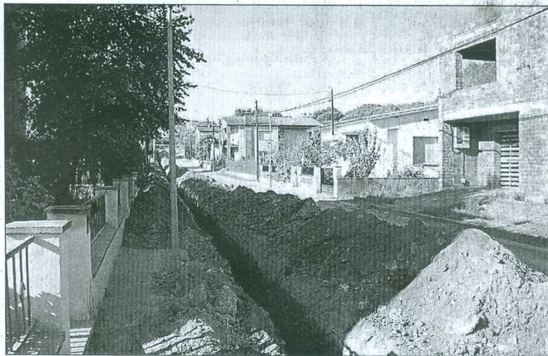
L'obertura dels carrers per fer les canalitzacions i soterrar els serveis ha començat aquesta setmana. Foto: S. GENOHER.
