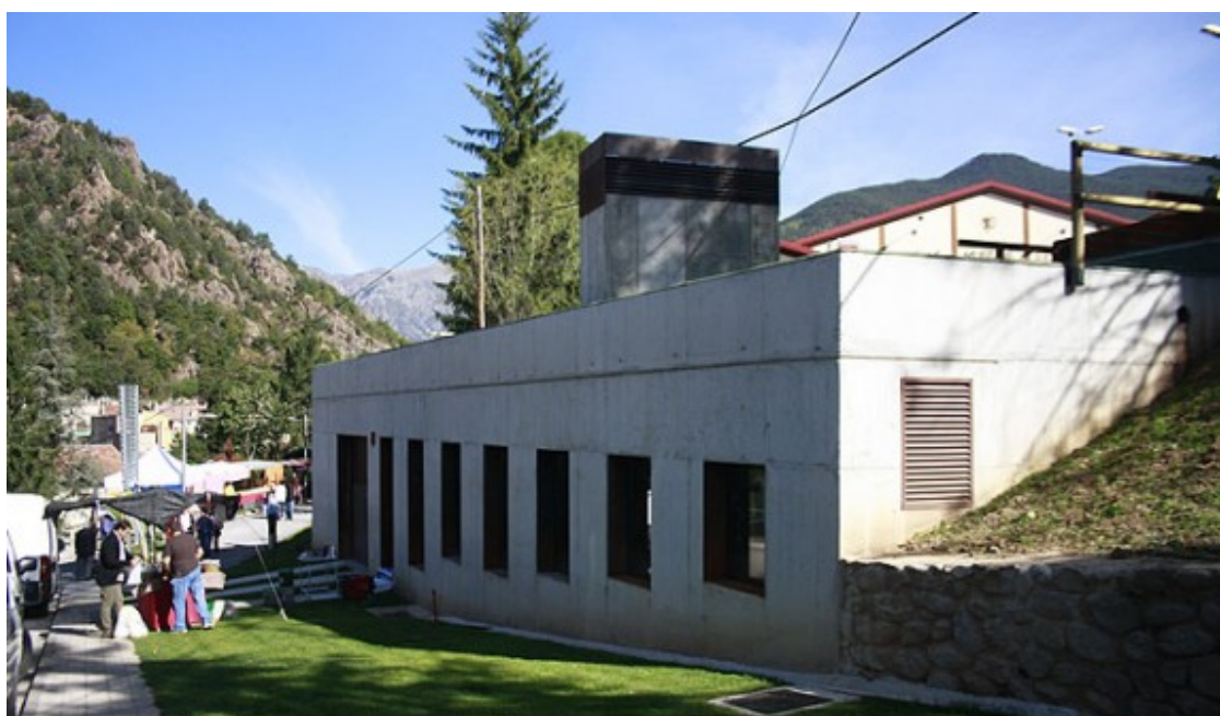
Edifici que acull les calderes de biomassa. Foto: Arnau Urgell
