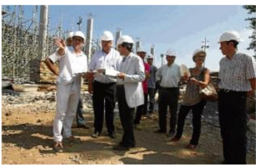
Visita institucional a les obres al nou parc de bombers, des del mes de març en fase de construcció.
