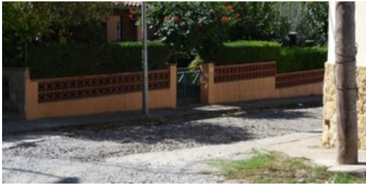
Tram del carrer de Tarragona a l'Escala que està encara per asfaltar. Foto: JOAN PUNTÍ.
