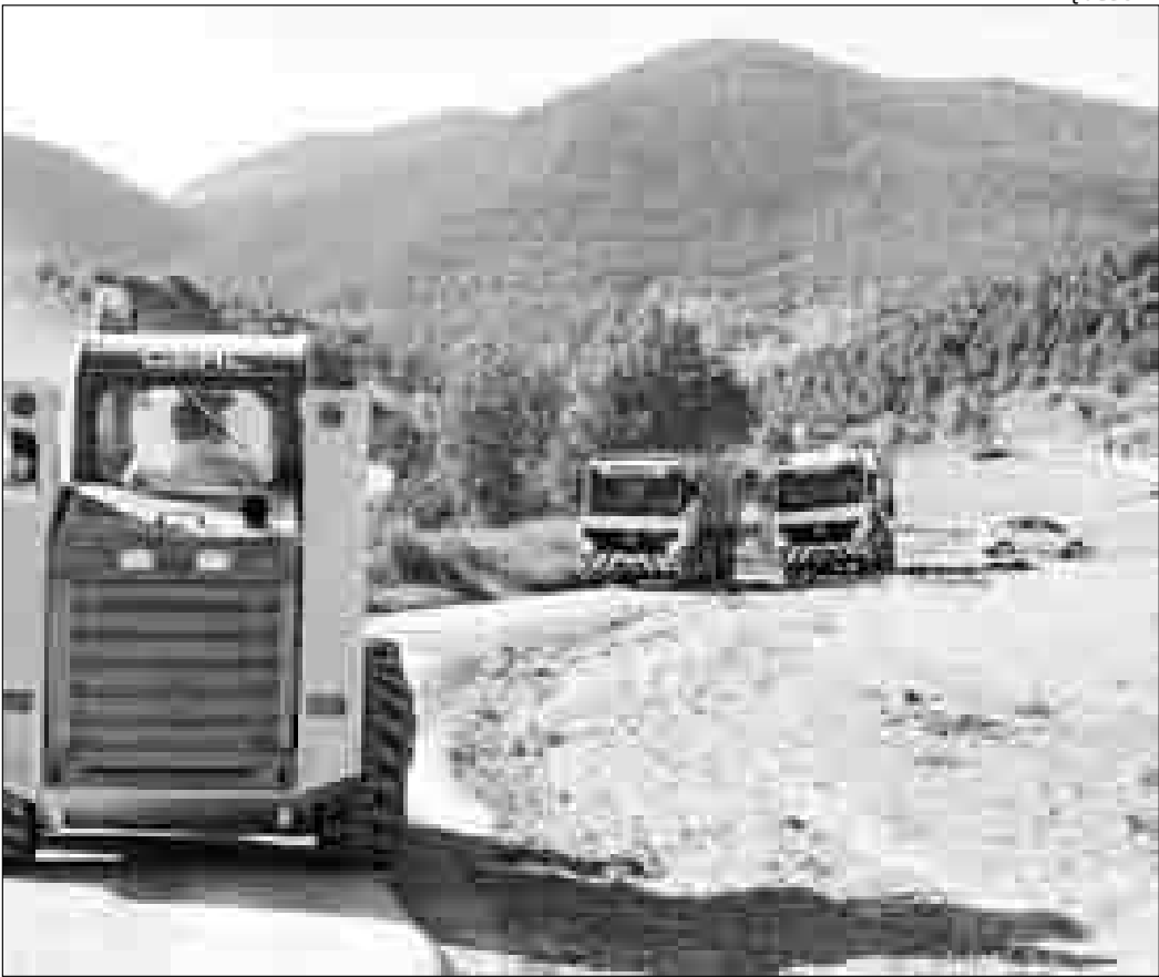
Les màquines arreglant, aquesta setmana, la carretera de Vilella
