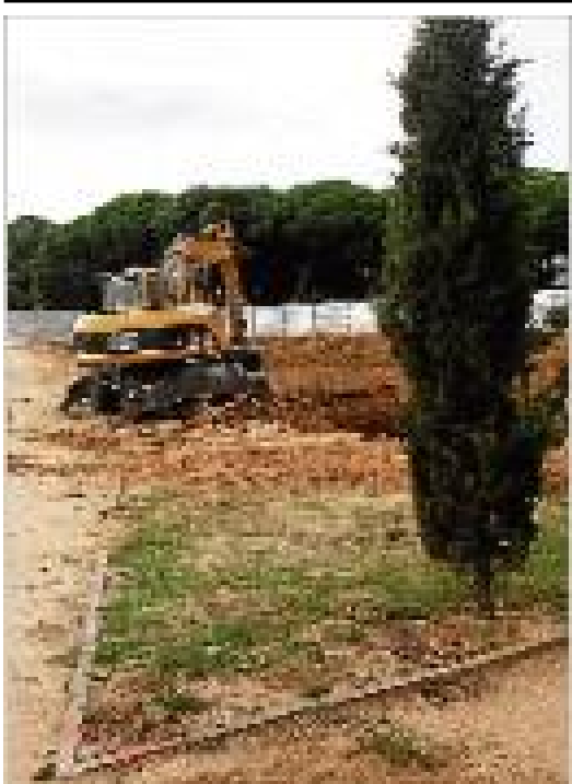
Una excavadora treballant al solar.
