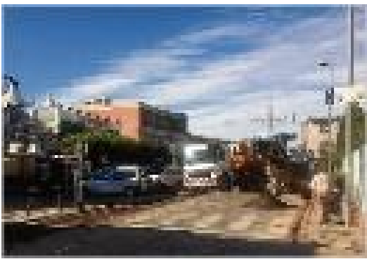
Comença l'asfaltatge del segon tram del carrer Costa Brava
