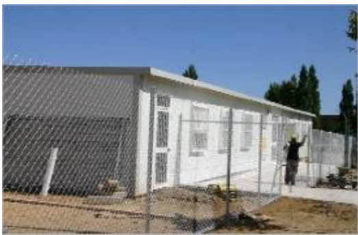
Últims treballs per adequar els barracons de la nova escola de Banyoles.
