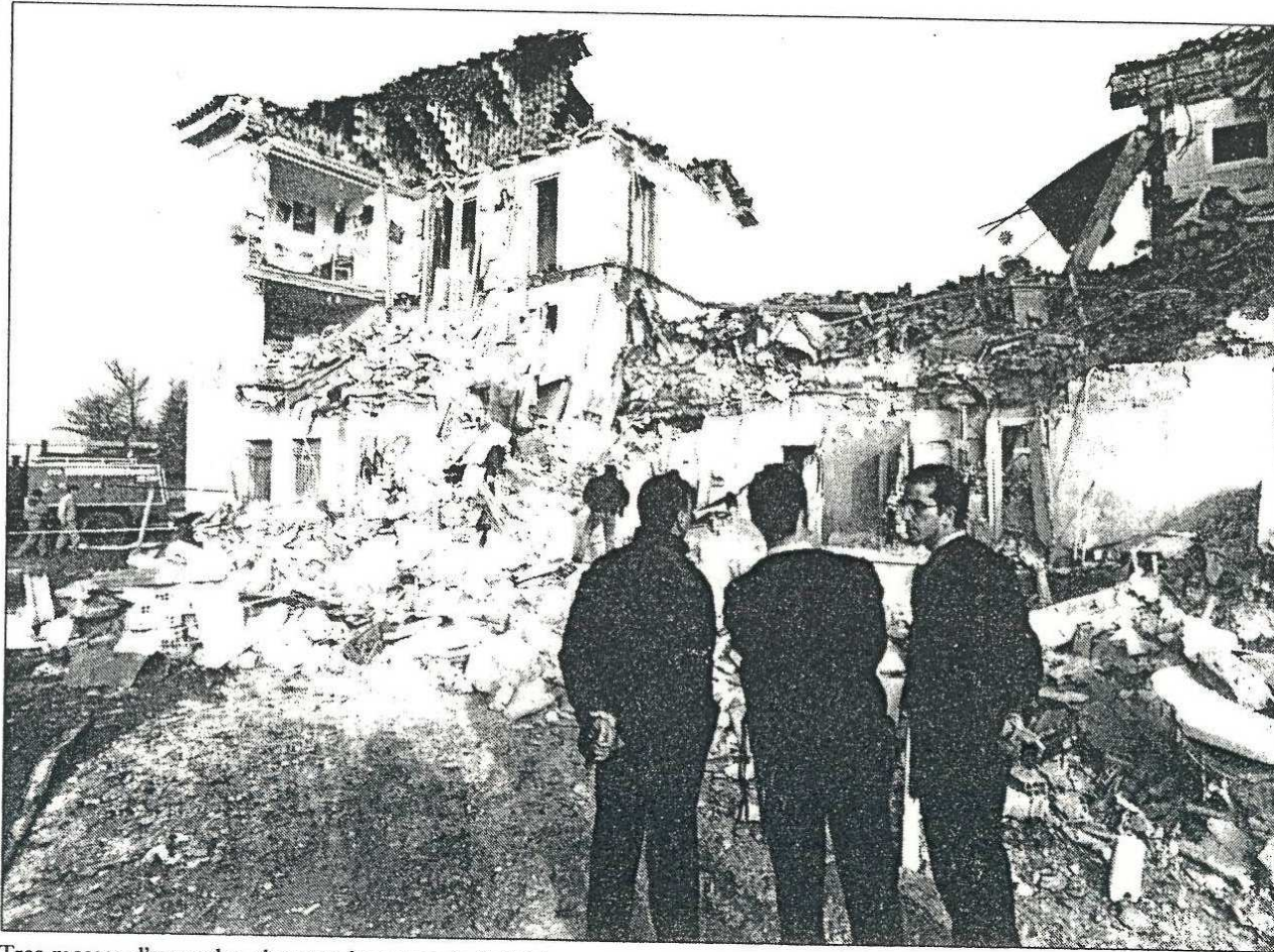
Tres mossos d'esquadra observen les runes de l'edifici.
