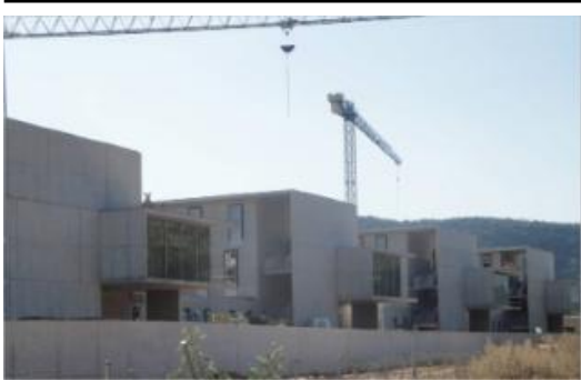
La part exterior del nou Hospital Comarcal de la Garrotxa està pràcticament acabada.
