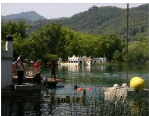
Imatge d'ahir, durant la instal·lació dels blocs de formigó a l'Estany.
