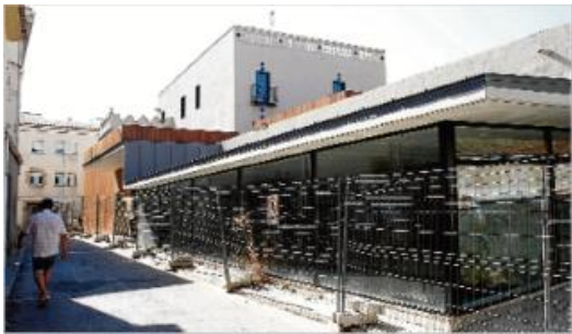
La biblioteca de Maçanet s'alça al pati de Can Trinxeria, on ara roman tancada a l'espera de reiniciar l'obra.
