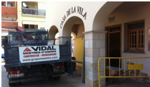
Obres a l'Ajuntament. Foto: N. Forn.
