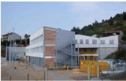
L'escola del Morrot té una superfície construïda de 3.108 metres quadrats.
