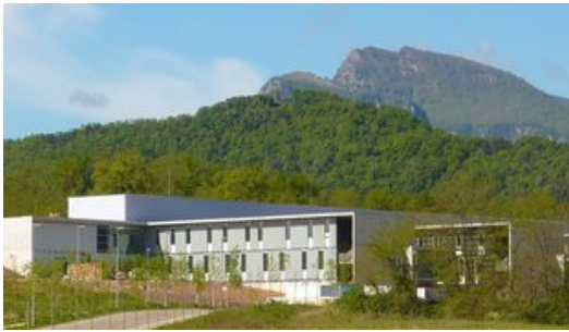
L'edifici del nou hospital, en obres, en una foto del mes de maig. Foto: R. E..
