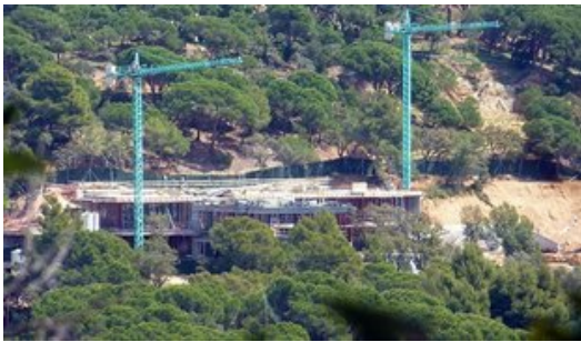
La nova construcció que s'està aixecant a Can Juncadella, de prop de 1.000m2. Foto: SOS LLORET.
