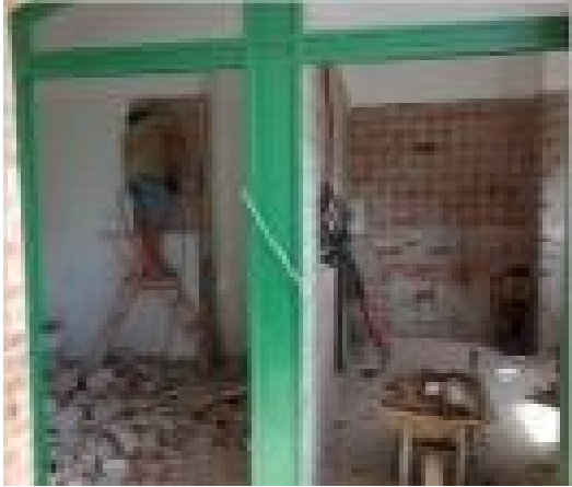
Reformes als lavabos del pavelló i del camp de futbol de Maçanet
