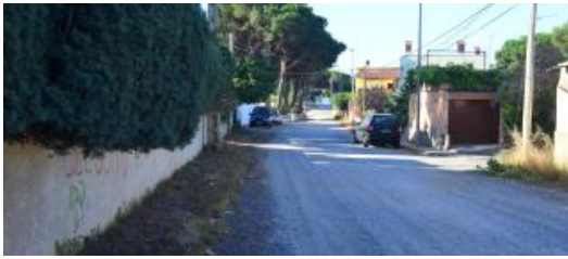
Estat actual d'una part del vial afectat per les obres
