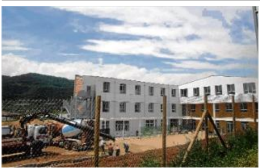
Construcció dels accessos a l'escola del Morrot, ahir a la tarda.
