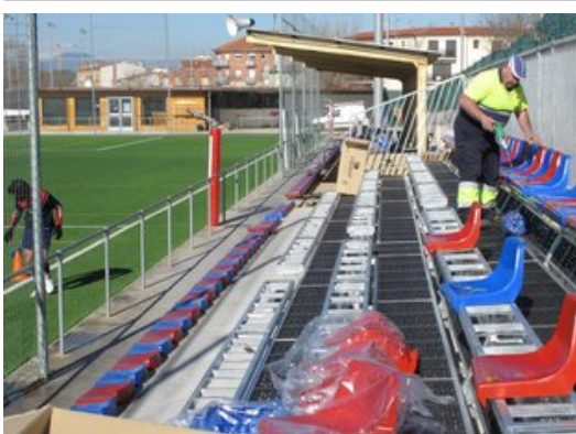
La instal·lació de grades és una de les darreres intervencions fetes a la zona esportiva Foto: J.N.
