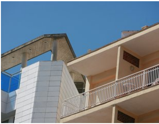
La víctima va saltar des del terrat de l'hotel on s'allotjava (a la dreta) al del costat Foto: M. LLADÓ.
