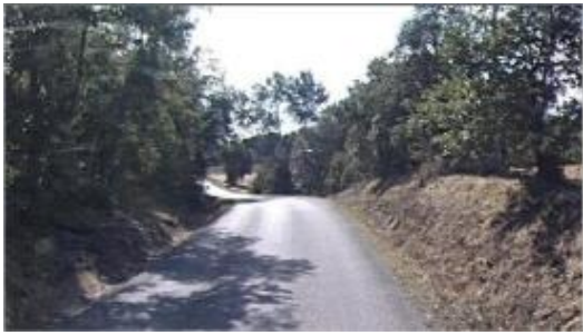
Imatge del tram d'accés a les urbanització que es millorarà.
