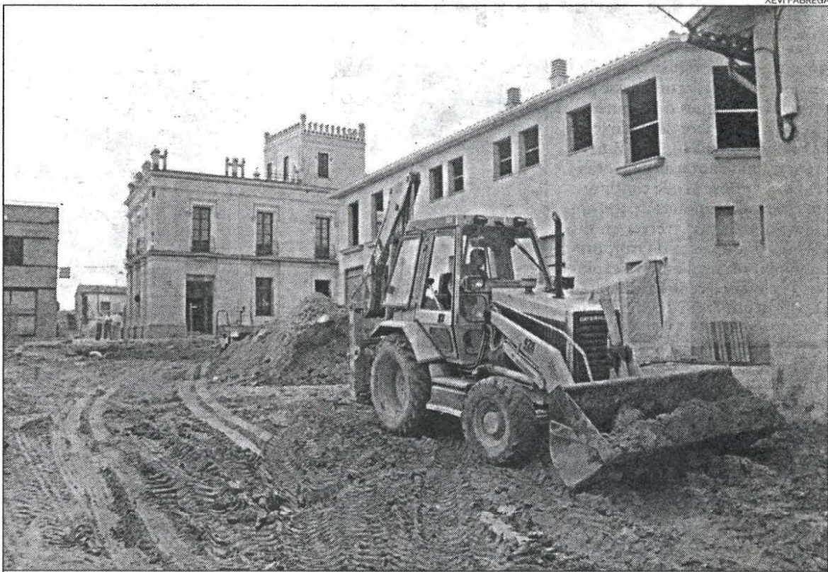
El sector de Cruïlles en obres. Miquel Casas va assegurar que el nou projecte ja eliminen les barreres arquitectòniques.
