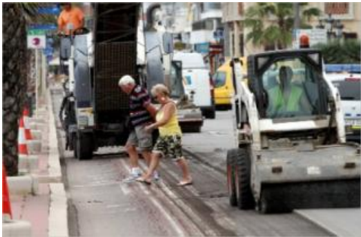
Lloret de Mar Comencen les obres del passeig aixecant el carril esport
