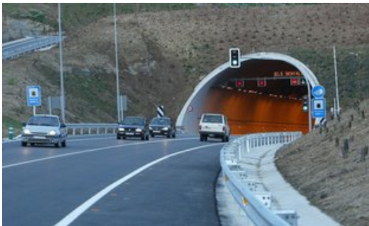
El túnel de Bracons ha incrementat les relacions entre Osona i la Garrotxa. Foto: J.C.
