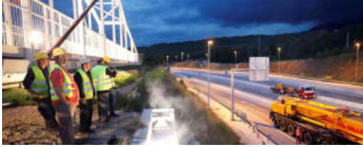
Diversos operaris treballen en la col·locació de la passera.
