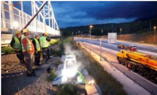
Diversos operaris treballen en la col·locació de la passera.
