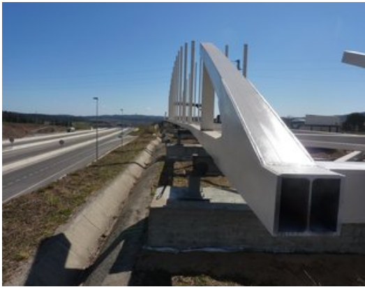
Detall de la passera, mentre l'estaven construïnt a la vora de l'autovia. Foto: R. E.
