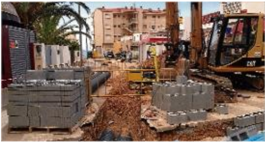
Les màquines treballant a les canalitzacions.
