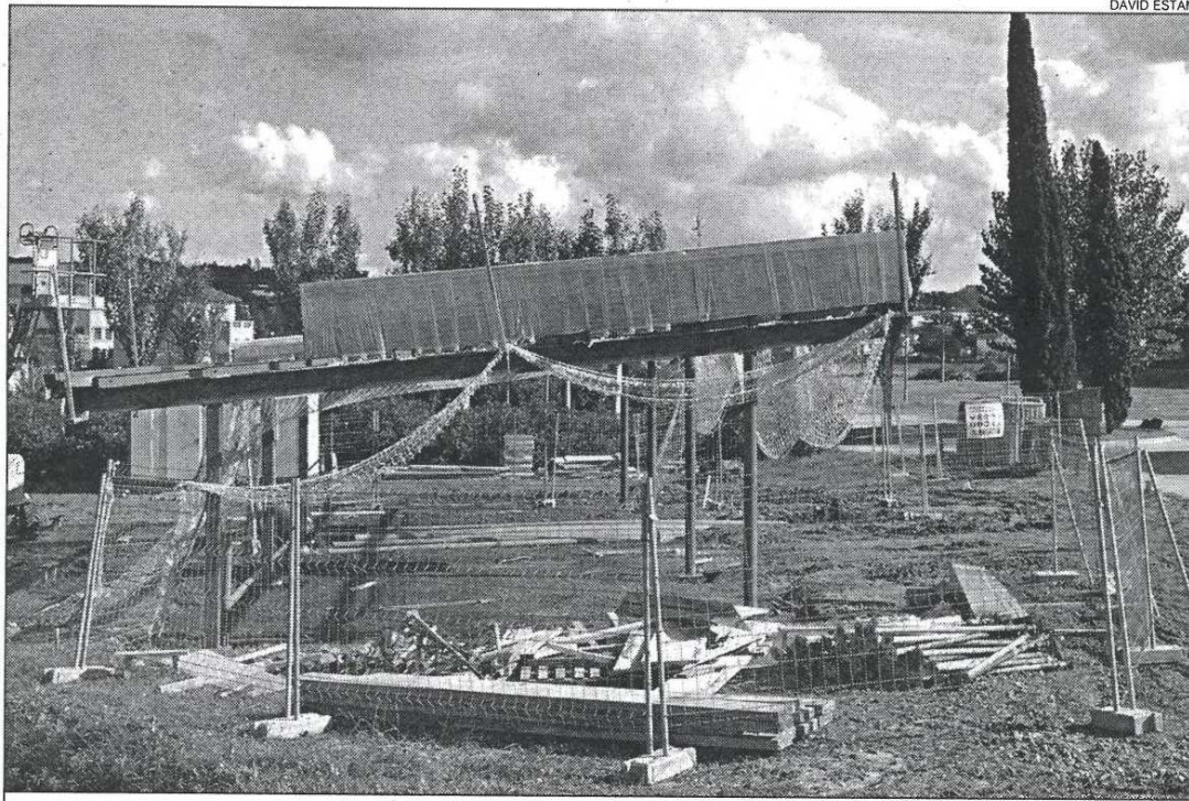
En construcció. Els treballs d'edificació de la nova oficina de turisme ja han començat.
