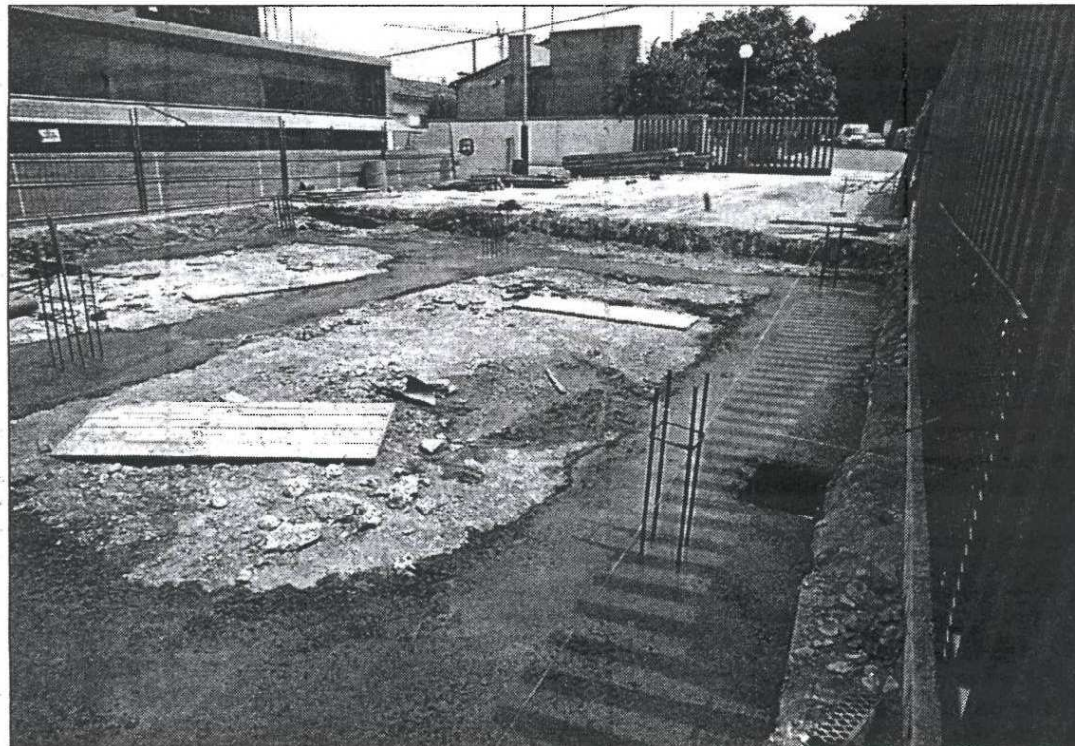
OBRES. Els treballs, que s'han iniciat recentment, finalitzaran el proper mes d'octubre.
