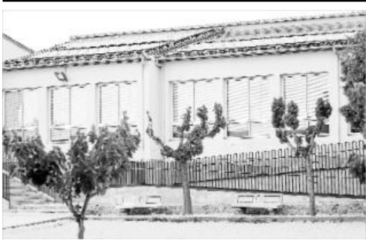
Les plaques solars instal·lades a l'escola Lacustària de Llagostera no arribaran a entrar en servei.
