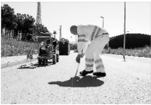
Fornells Pinten noves places d'aparcament
