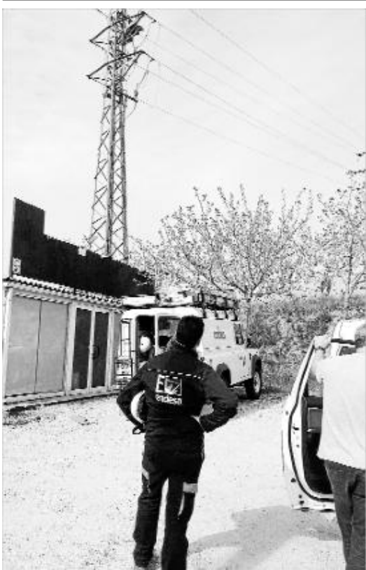
Uns operaris reparant una torre elèctrica ahir a Llagostera.
