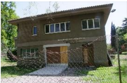
La depuradora vella al sector de les Feixes, a la Canya.
